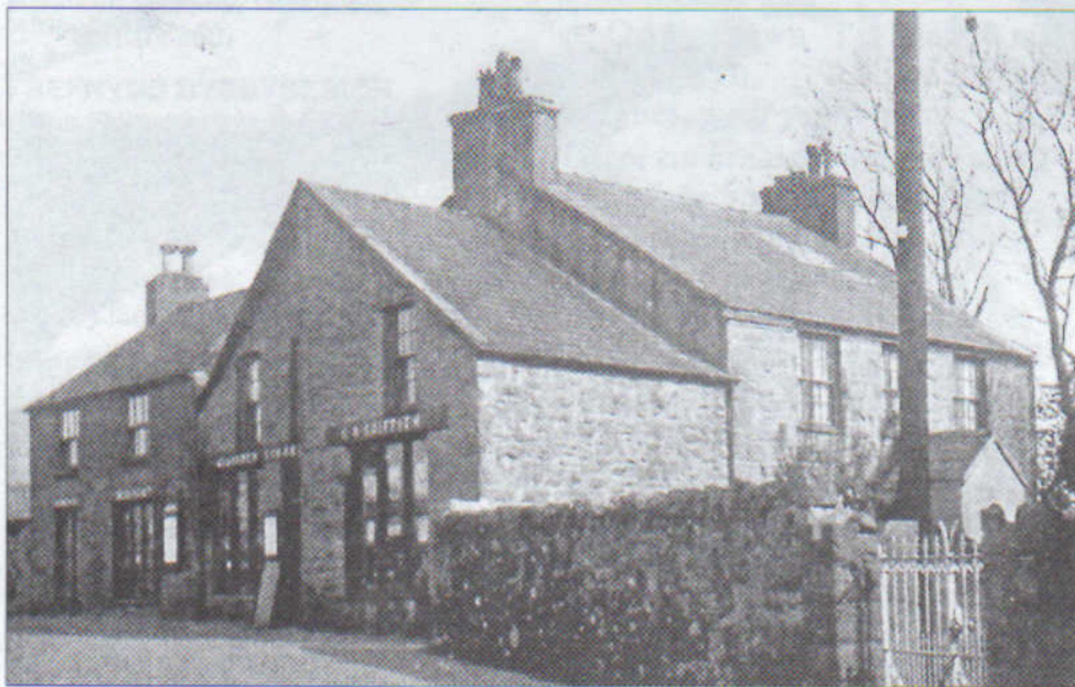
Glasgoed House a Glasgoed Stores, Peniarwaun.
